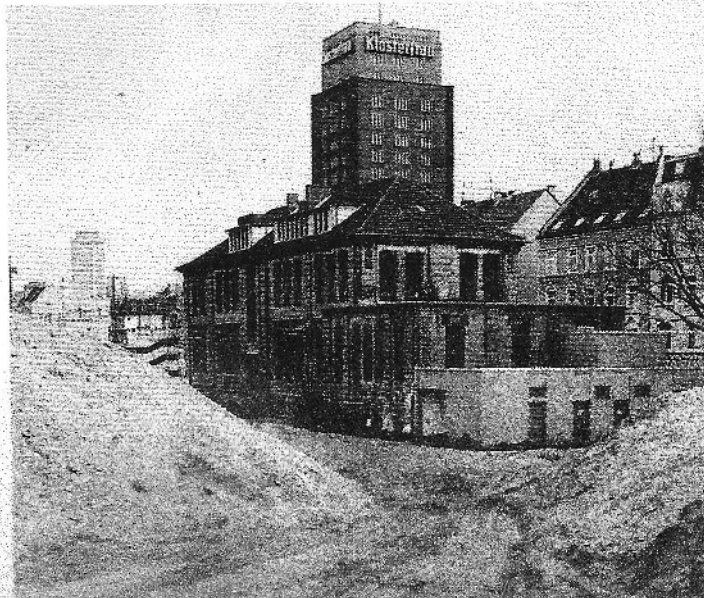
Nach 18 Jahren wieder Sanierungsfall: Filmhausbaustelle in den 90er Jahren
